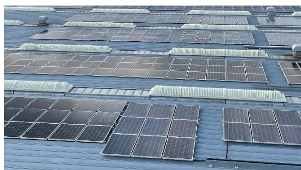
太陽光リユースパネル1,115枚（5種類の異なる仕様）設置事例
