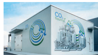
CO 2 循環プラント
