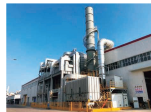
日立建機 中国安徽省 油圧ショベル工場
