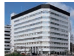
新町第1ビル 1988年竣工
