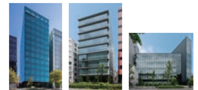
京阪神 虎ノ門ビル Sランク ★★★★★ 京阪神 御成門ビル Sランク ★★★★★ 京阪神 代々木公園ビル Sランク ★★★★★
