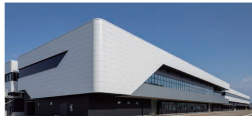
東大垣工場第4工場外観
