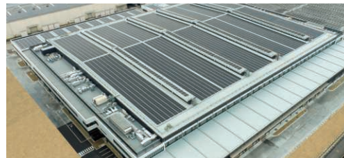
建屋の屋根に太陽光発電設備を設置
