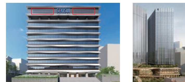
▲大阪本社ビル 外壁に実装 (赤枠内がフィルム型ペロブスカイト太陽電池)
