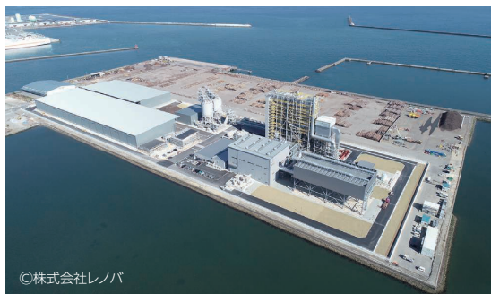
徳島津田バイオマス発電所 (徳島県徳島市) 発注者:徳島津田バイオマス発電所合同会社
