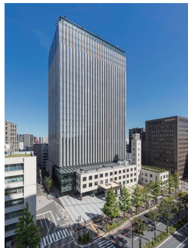
川崎市新本庁舎超高層棟新築工事 (神奈川県川崎市) 発注者:川崎市
