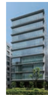
御成門ビル 2009年竣工
