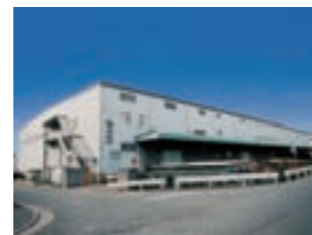
枚方倉庫 1983年竣工
