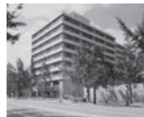
瓦町ビル 1962年竣工
